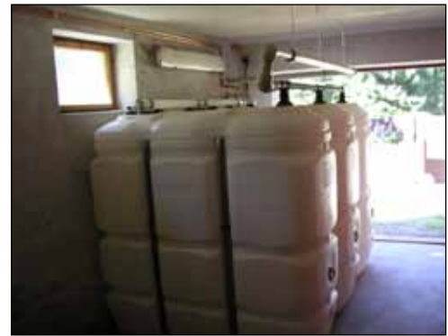
Nádrže na lehký topný olej mohou být umístěny v samostatné místnosti, nebo například v garáži. THERMOIL
